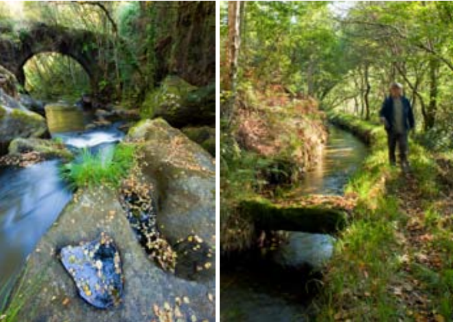
Acueduto de Leira GPS. 42° 38' 28.4" N 8° 26' 5.97" O
